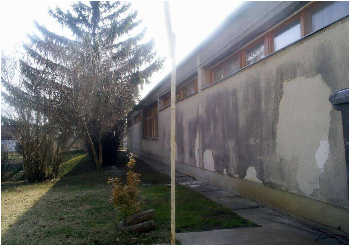
3. Kép Északi homlokzat, vizesedés nyomai
