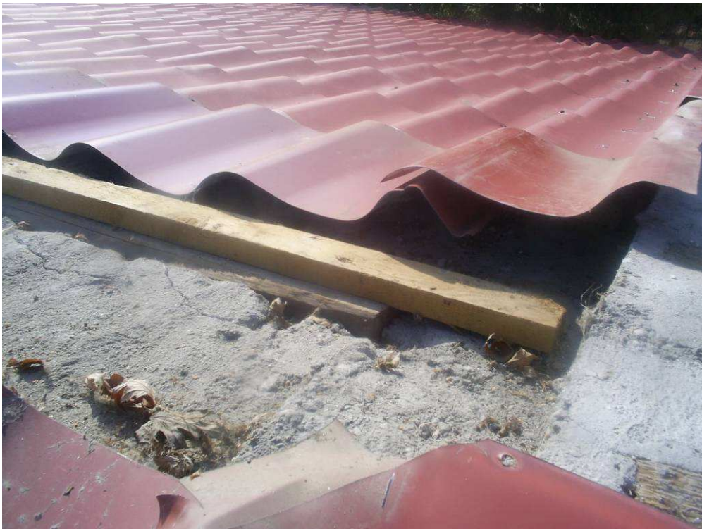
1. Kép A tetőt megbontva látható, hogy nincs jelenleg szigetelve
