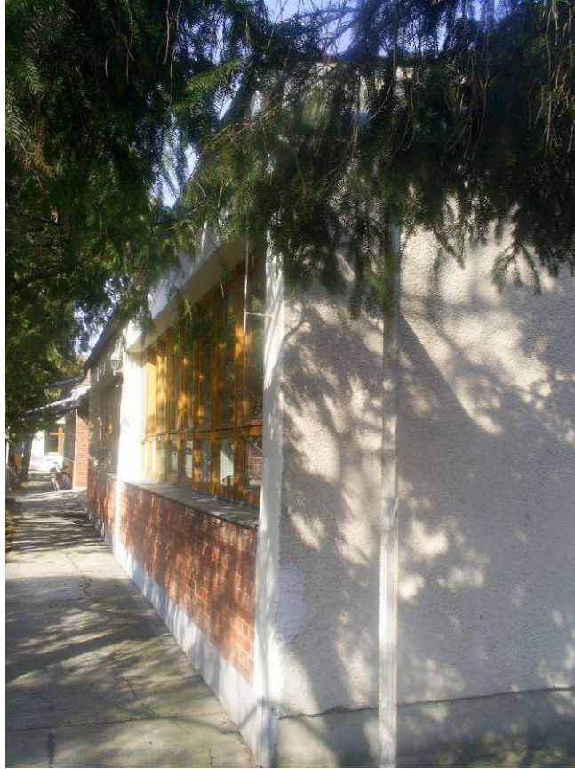
4. Kép Déli homlokzat
