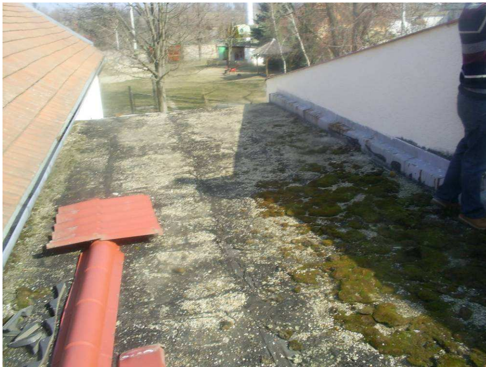
2. Kép A nyaktag földeme szigetelés nélküli, beázik
