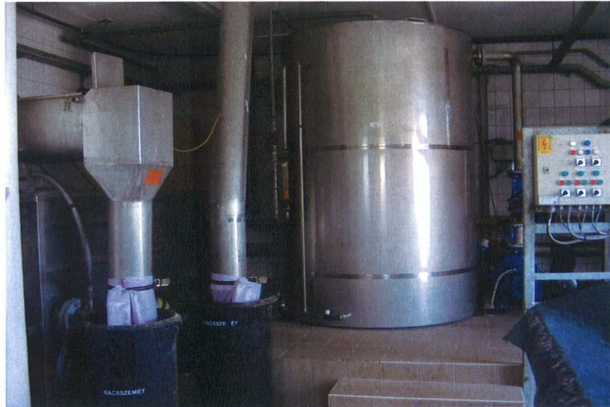
3. számú kép: Települési kommunális folyékony hulladék ürítőhely rácsgépháza a makói szennyvíztisztító telepen
