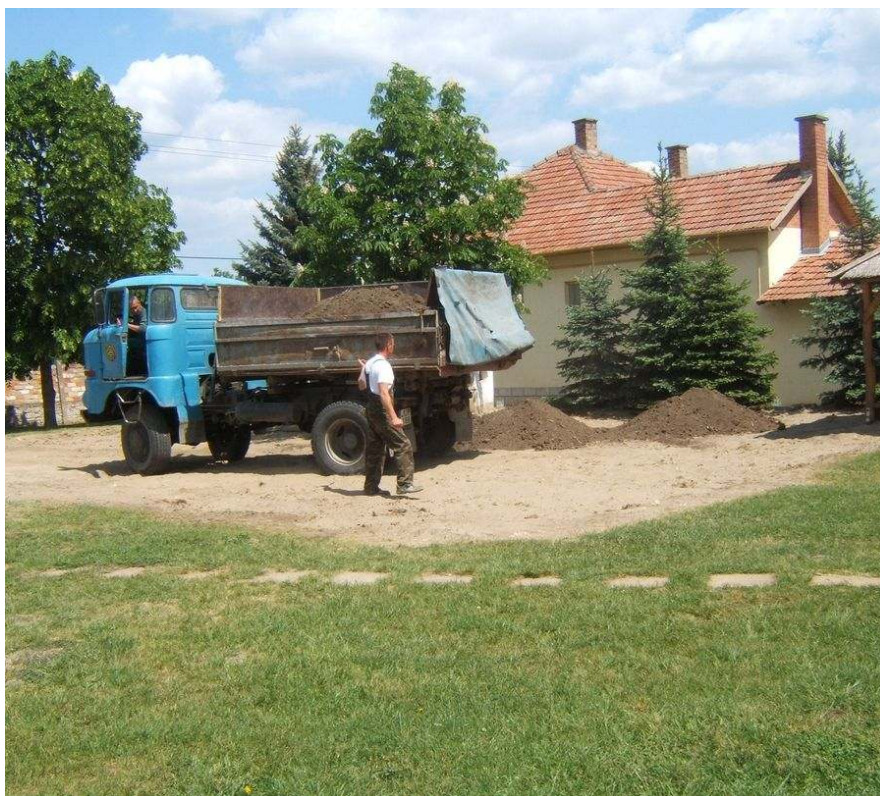
Termőföld elterítése és füvesítés a hátsó udvaron.
